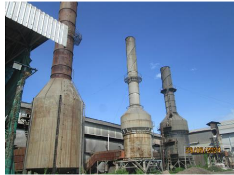
รูป 2-2 : ปุ่มล้างสำหรับระบบควบคุมมลพิษอากาศ (Wet Scrubber)
