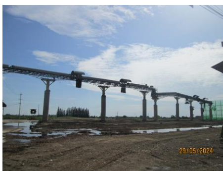
รูป 2-10 : การปิดครอบระบบสายพานลำเลียง เพื่อลดการฟุ้งของฝุ่น
